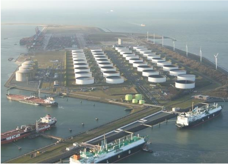
Figur 17: LNG terminalen i Maasvlakte i Rotterdam. Disse kan i teorien utvikles og brukes til hydrogenlagring. Her ser vi hvor tilgjengelig slik teknologi kan være i store havner. (Greenport, 2016)
