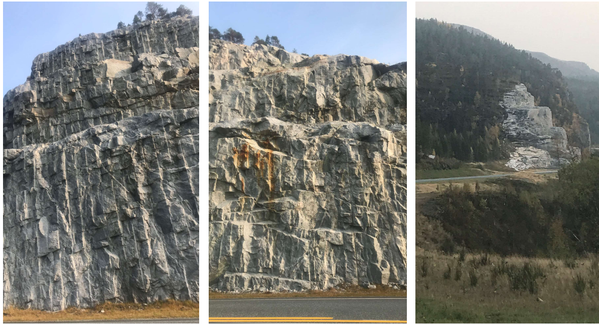
Figur 50: Inntrykksbilder fra bergskjæring 2 tilhørende prosjektet Osavetnet-Rødsjø
