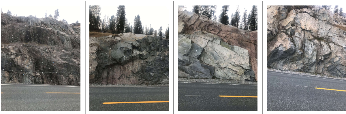
Figur 62: Intrykksbilder fra bergskjæring 2 tilhørende prosjektet Nordsetervatnet
