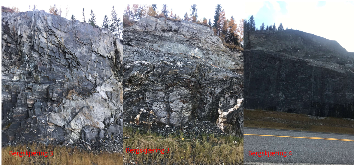
Figur 40: Inntrykksbilder bergskjæring 3 og 4
