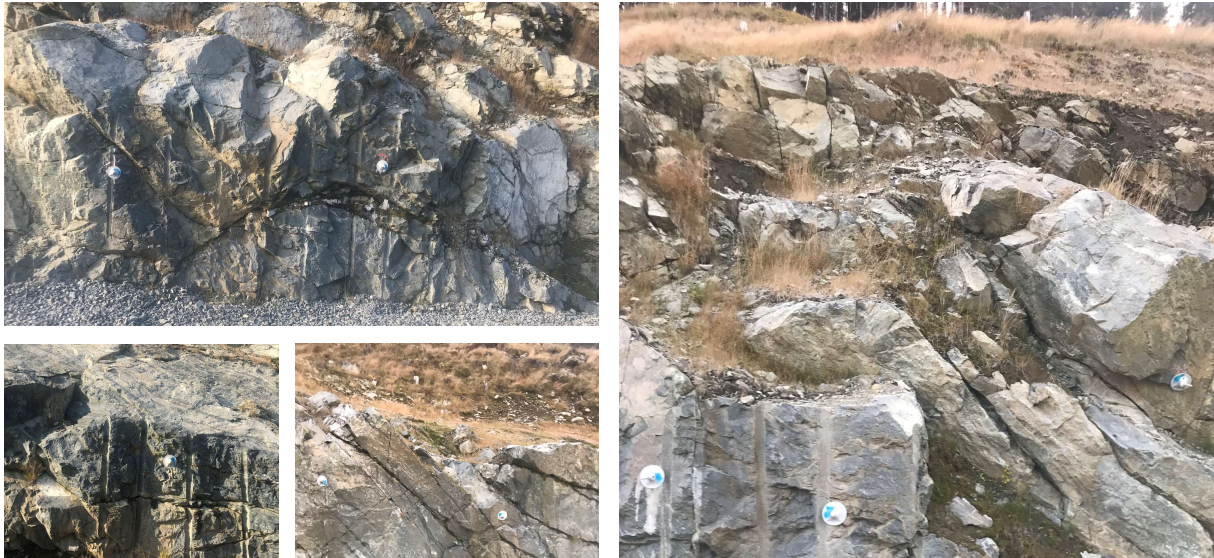
Figur 64: Inntrykksbilder fra bergskjæring 3 tilhørende prosjektet Nordsetervatnet
