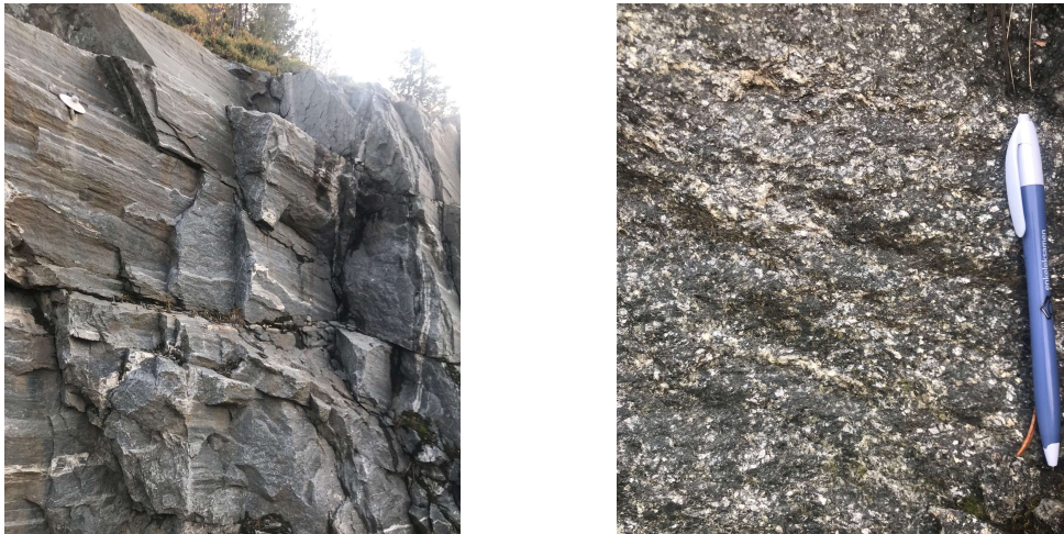
Figur 54: Inntrykksbilder fra bergskjæring 4 tilhørende prosjektet Osavetnet-Rødsjø
