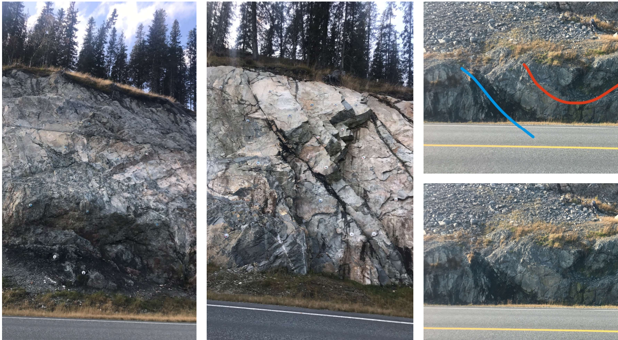
Figur 67: Inntrykksbilder fra bergskjæring 5 tilhørende prosjektet Nordsetervatnet
