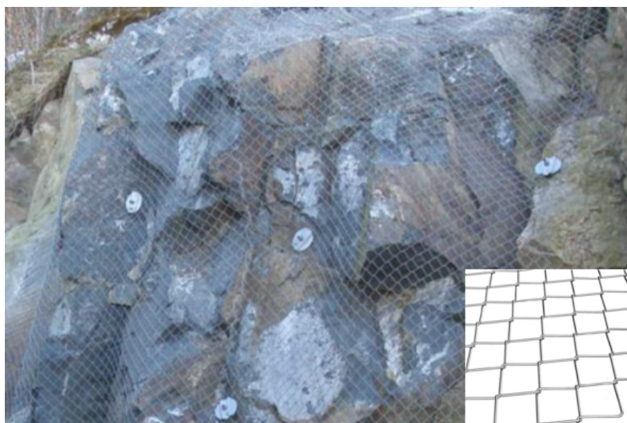
Figur 2.30: Flettverksnett montert på fjellveg (Bjordal et al., 2011).
