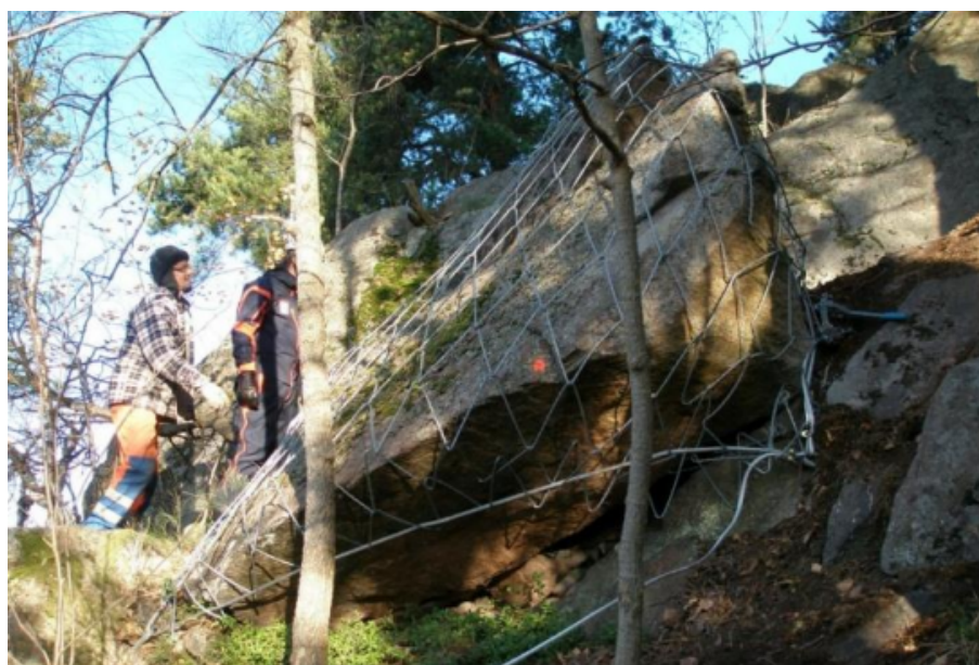
Figur 2.33: Figuren viser bruk av wirenett for å holde tilbake en stor ustabil blokk (Bjordal et al., 2011).
