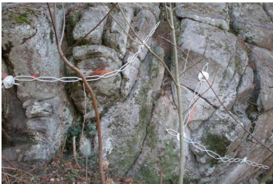
Figur 2.32: Fjellbånd montert for å holde tilbake ustabile blokker (Bjordal et al., 2011).
