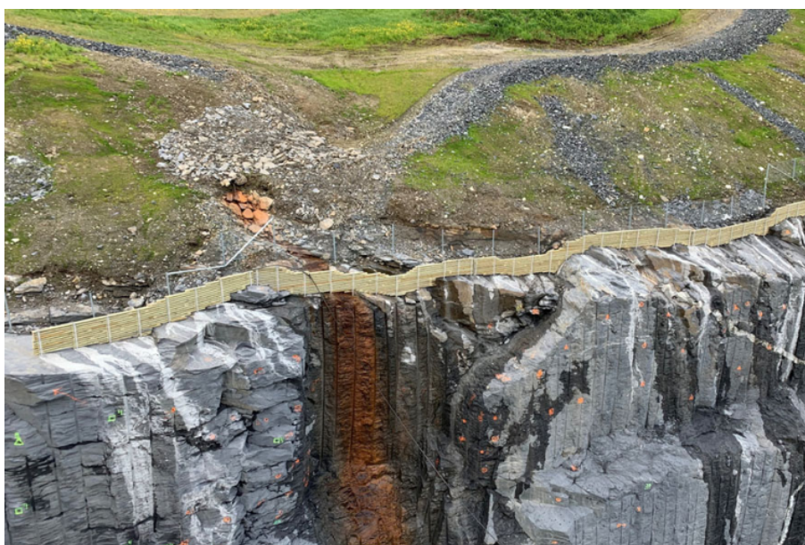
Figur 2.35: Sognemur brukes for å holde tilbake overliggende masser (Gjerdens Fjellsikring, 2020).
