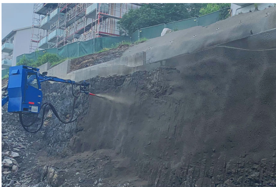
Figur 2.34: Sprøytebetong påført med maskin (Gjerdens Fjellsikring, 2020).
