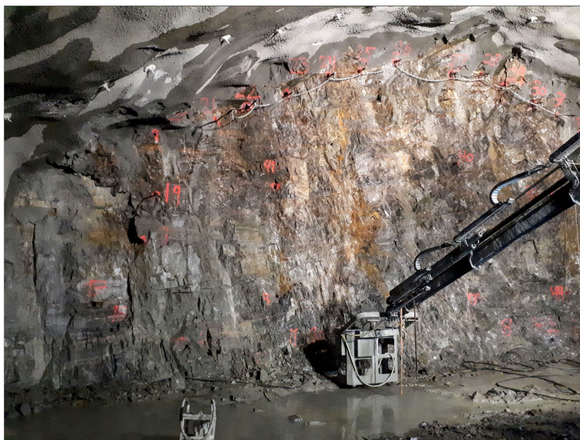
Figur 8.7: Longva-stuffen ved pel nr. 23654 (parti 3) under befaring 19.02.2020. Legg merke til horisontal struktur (foliasjon) i gneisen, særlig tydelig til venstre. Profilene er utvidet for havarilomme (Birkeli, 2020).
