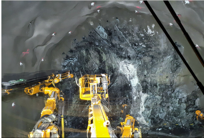
Figur 8.15: Stuff fotografert fra borryggen under befaring, ved pel nr. 32202 (Birkeli, 2020).
