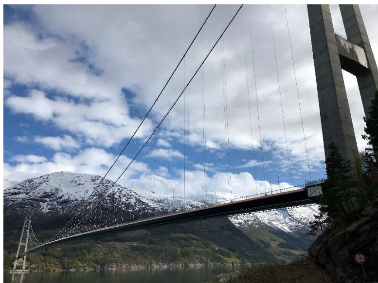
Figur 6.1: Hardangerbrua sett fra Tjoflotvegen i Vallavik.
