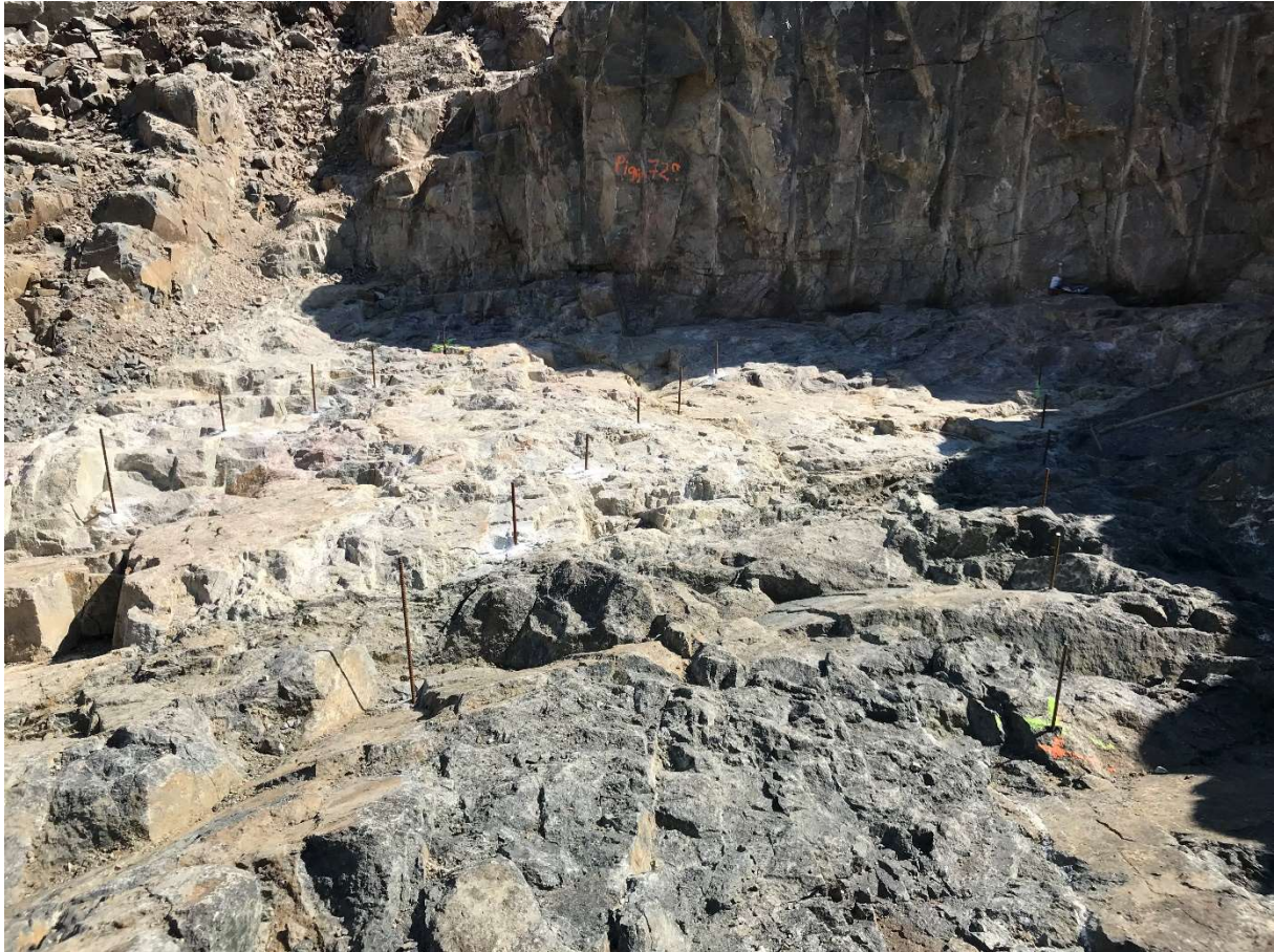
Figur 1.1: Rensket bergsåle forut for etablering av fundament i forbindelse med utbygging av E18 Rugtvedt–Dørdal. Foto: Roger Olsson.
