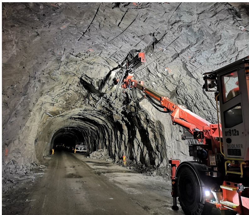
Boring av salvehull ved strossing av Forsattunnelen
