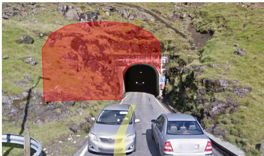
Figur 1.1: Illustrasjon for hvilken del av tunnelverrsnittet i Hvannasundstunnilin som skal strosses, markert med rødt område. Tunnelen er enveiskjørt med møteplasser og bildet gir inntrykk av hvor smal den er. Bildet er hentet fra Google Earth (2020).
