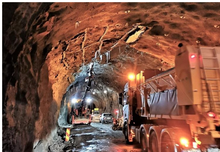
Figur 5.4: Boring av resterende salvehull for driving av halvt tunnelprofil i Forsatunnelen (Godtland, 2019). Boringen måtte stoppe opp når trafikkolonnen passerte.
