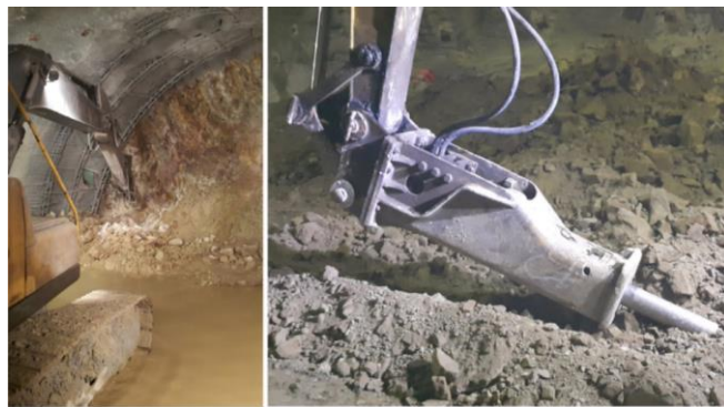
Figur 4.7: Bruk av pigghammer under driving av ny vegtunnel i Istanbul (Ocak et al., 2018).
