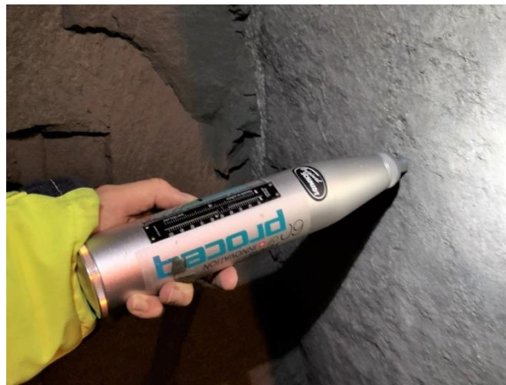
Figur 6.8: Måling av rekylverdi med Schmidt-hammer på sprekkeplan (SPL1) i Leirvikartunnelen.
