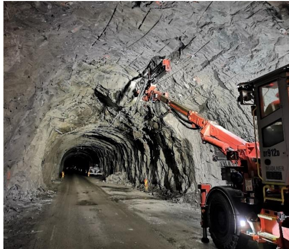
Figur 4.3: Boring av salvehull i Forsatunnelen for strossing av tunnelverrsnitt T7,5 til T8,5 (Godtland , 2019).
