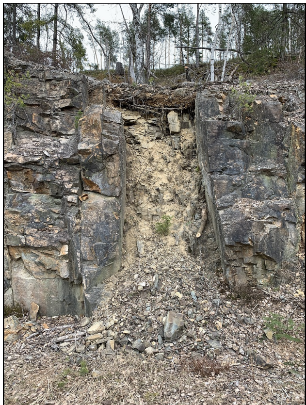
Figur 8.2: Sone med oppsprukket diabas langs den gamle jernbanelinja for Drammensbanen. Foto: Roger Olsson 29.03.2020.
