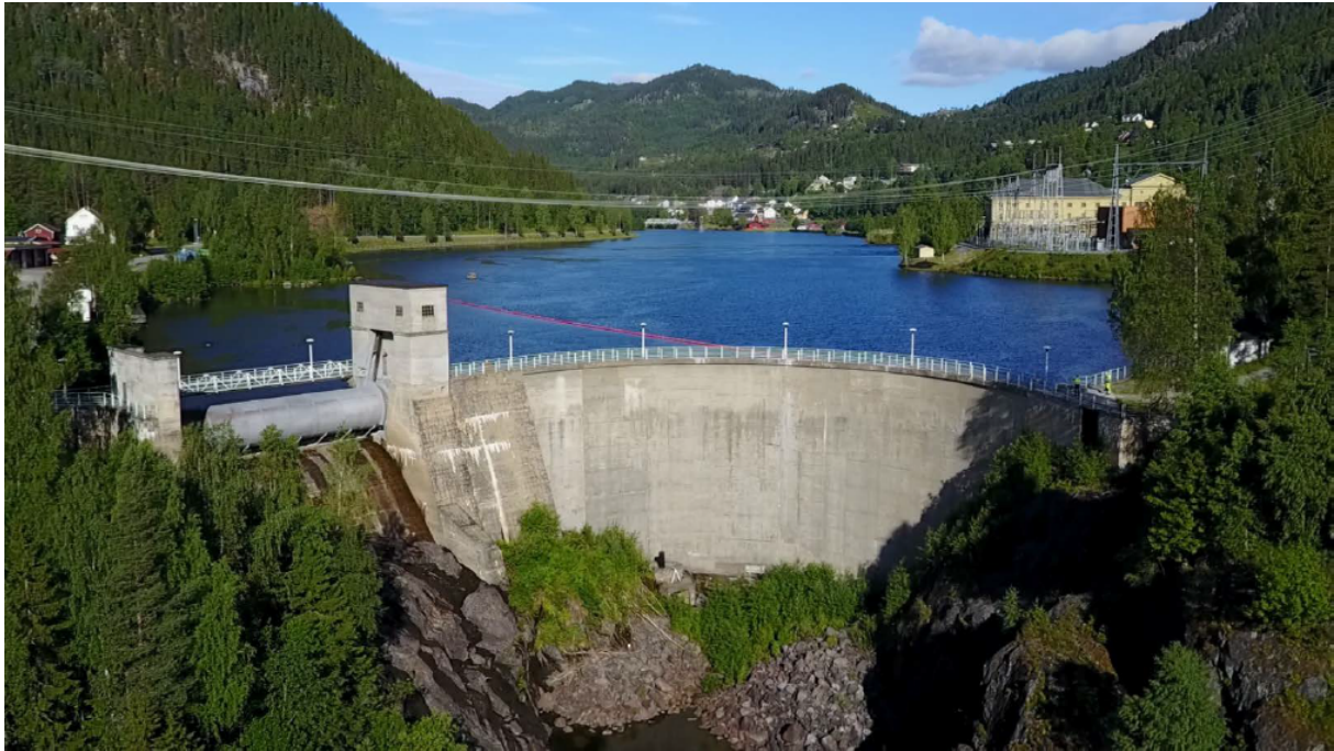
Figur 1.4: Bilete av dam Statkraft. Foto: Cautus Geo AS.
