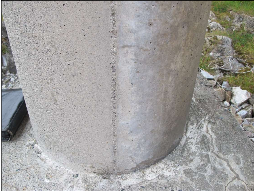
Figur 4-2 Værutsatte flater på søyle i akse 2 [24]
