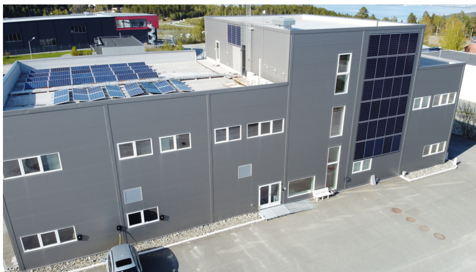
Figur 3.2: Sveberg Teknosenter med solcelleinstallasjoner [60]
