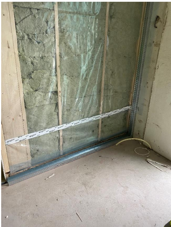
Figur 18 - Tape i dampsperreskjøt
