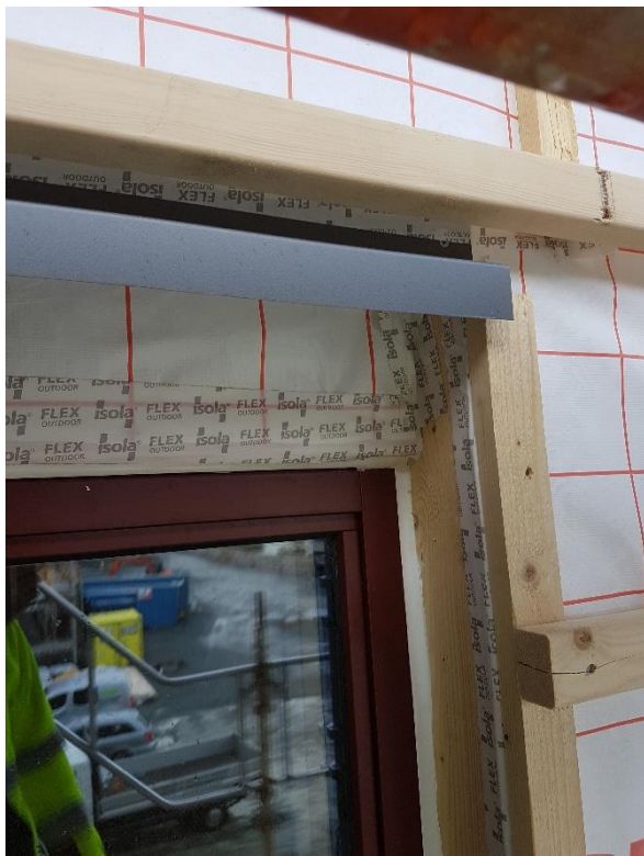
Figur 20 - Taping mot vindu og beslag (tilsendt)
