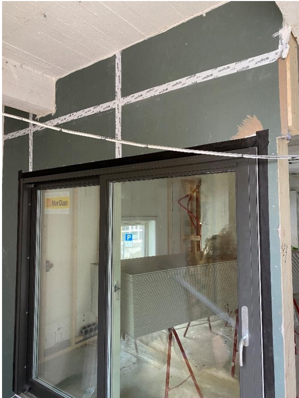
Figur 19 - Tape i vindspærresjikt
