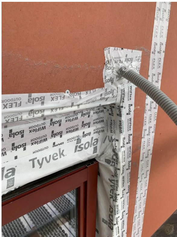
Figur 24 - Taping mot vindu
