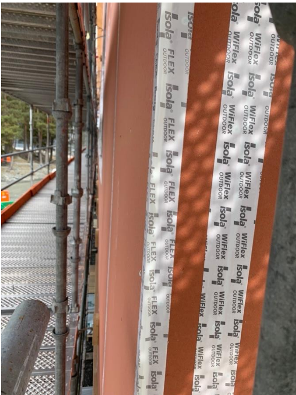
Figur 22 - Taping av skråskårne gipsplater
