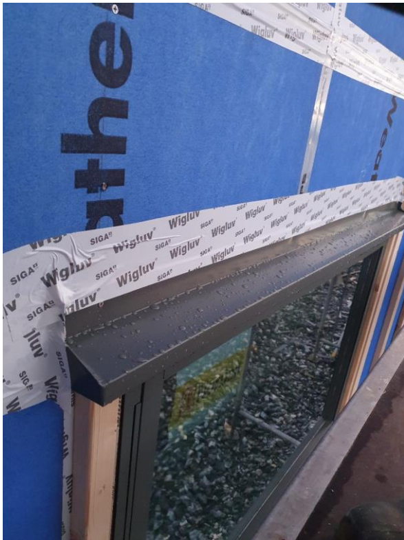
Figur 25 - Taping mot beslag (tilsendt)
