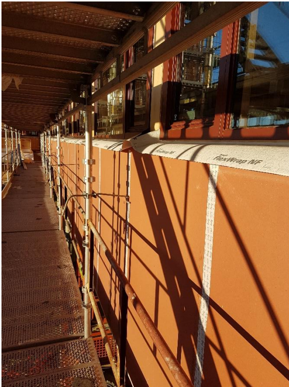
Figur 21 – Membran i underkant av vindu (tilsendt)
