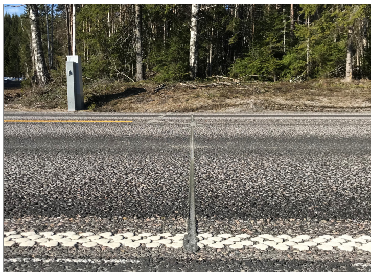
Figur 2.3: Nedfelt piezoelektrisk kabel ved ATK-punktet Øksna S (Foto: Tor Andreas B. Solheim)
