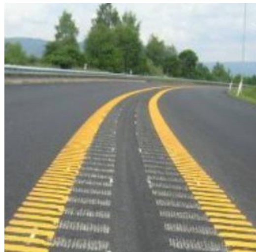
Figur 35 Illustrasjonsbilde til en midtrumlerille (kilde: https://www.tshandbok.no/del-2/3-trafikkregulering/326-forsterket-midtoppmerking/ )
