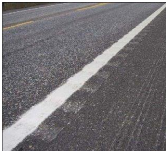
Figur 39 Illustrasjonsbilde av en kantrumlerille (kilde: Forsterket vegoppmerking, Terje Giæver)
