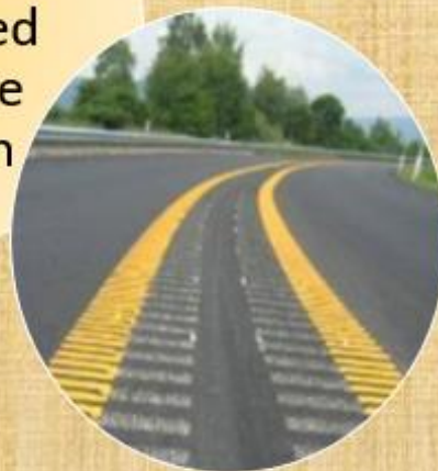
Forsterket midtoppmerking (rumleriller i Asfalten)
