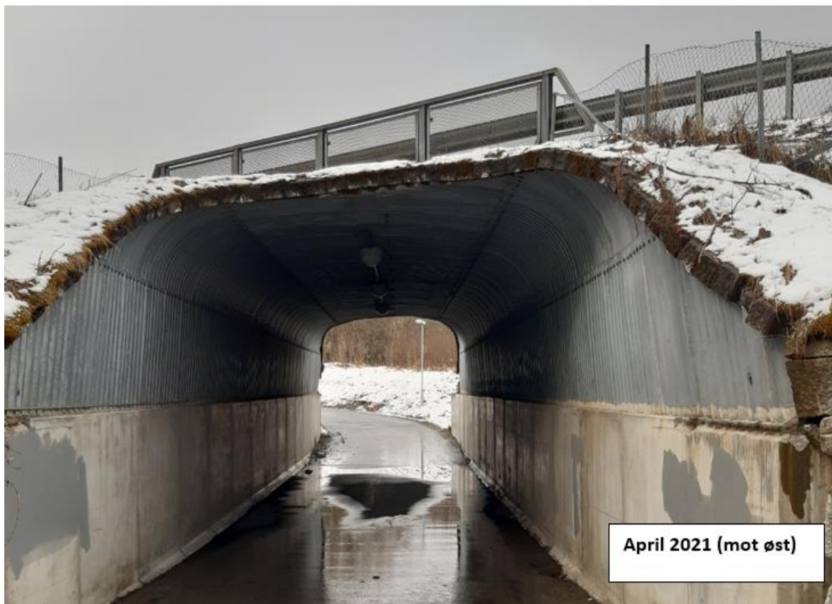
Figur 10 Gang- og sykkel feltet under Lundamoveien med rekkverk og brogjerder (fotokreditt: Saad Alrajeh)
