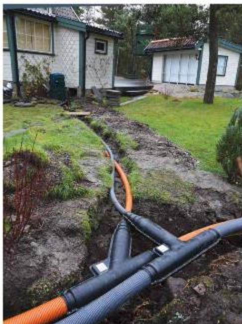
Figur 24: Y-kobling (venstre, rød ledning)
