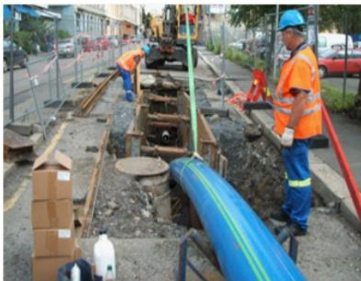
Figur 21: Utblokking krever plass til innføring av røret (53)
