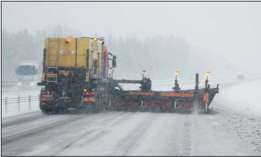
Figur 17: Lastebil som utfører brøyting med sideplog. Foto: Mähler International.
