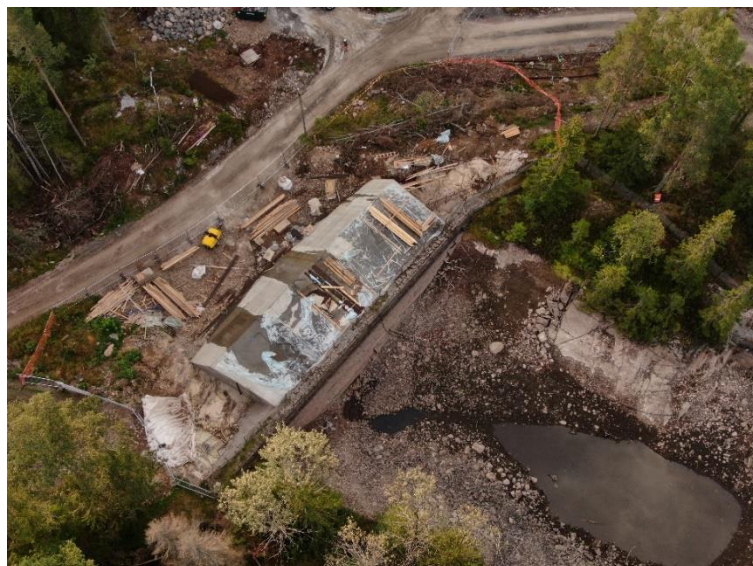
Figur 29 – Dronebilde av ferdig støpt damkonstruksjon
