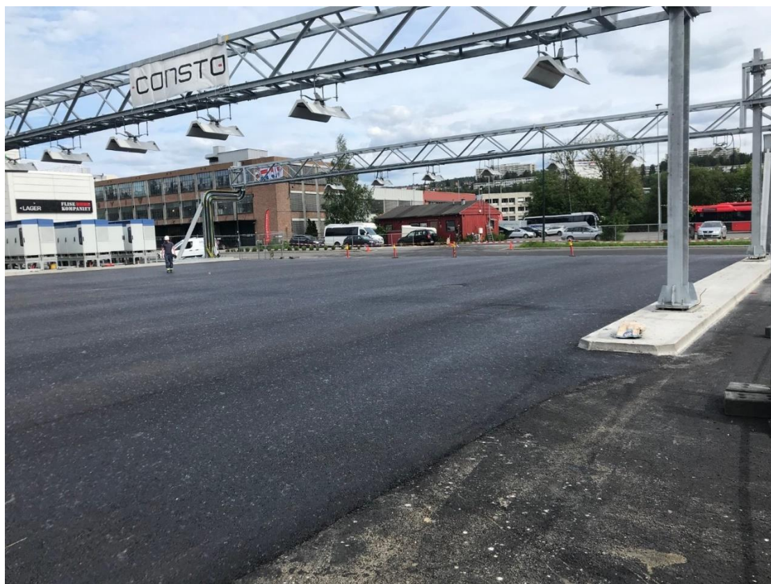
Figur 32 – Ferdig lagt Agb asfalt
