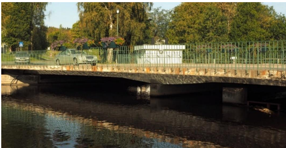
Figur 2-2 Gamle Nysethvegen bru. Sett fra oversiden damanlegg. (7)
