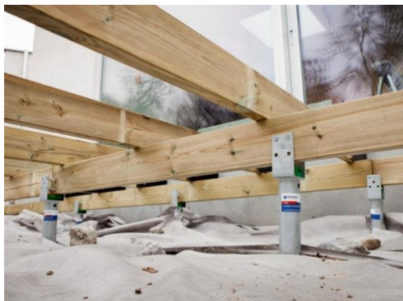
Figur 17: Skruefundament festet i bjelkelag (87).
