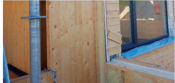
Figur 46: Ydalir skole i Elverum. Massivtrebygg isolert med Iso3 fra Moelven. Foto: Svein Egil Holmsen (78).
