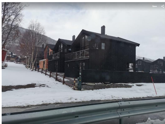
Figur 35 Nye fritidsboliger under oppføring på Sletvoldtunet. Foto: Hanssen I B.
