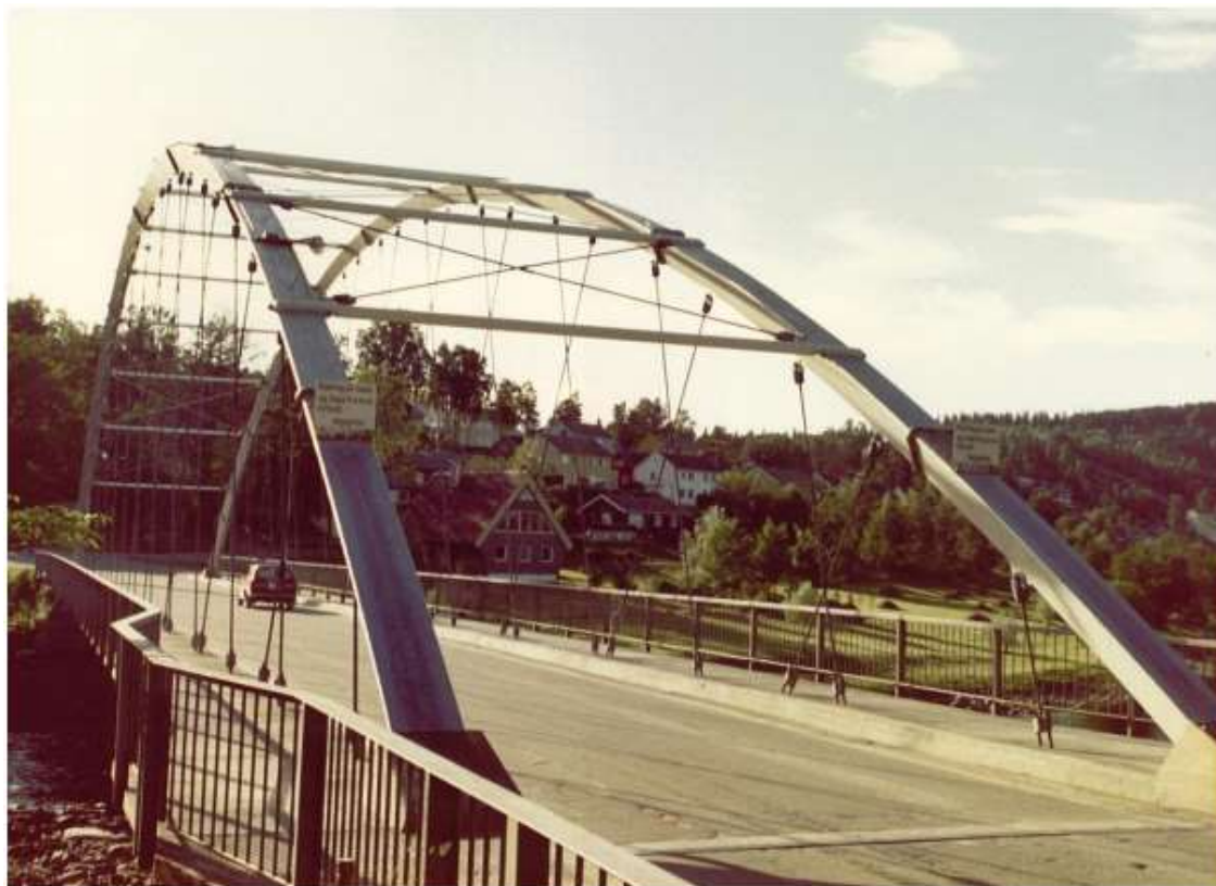
Figur 2-1: Den første nettverksbuebrua, Håkkadalbrua (Tveit, 2013)
