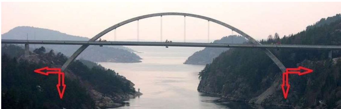
Figur 4-5: Svinesundbrua, buebrua med lengst hovedspenn i Norge, med opplagerkrefter for buen (Skoglund, 2019)
