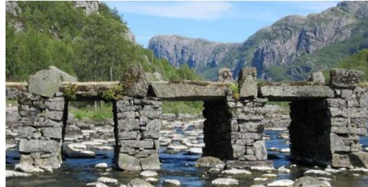
Figur 4-2: Steinhellebrua Terland klopp i Egersund kommune (BRR, 2009)
