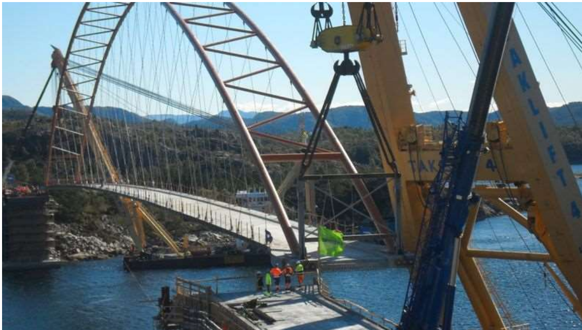
Figur 2-2: Brandangersundbrua løftes på plass (Hjelle, 2010)
