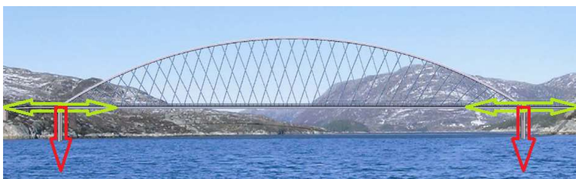
Figur 4-6: Brandangersundbrua med opplagerkrefter (Dalen, 2006)
