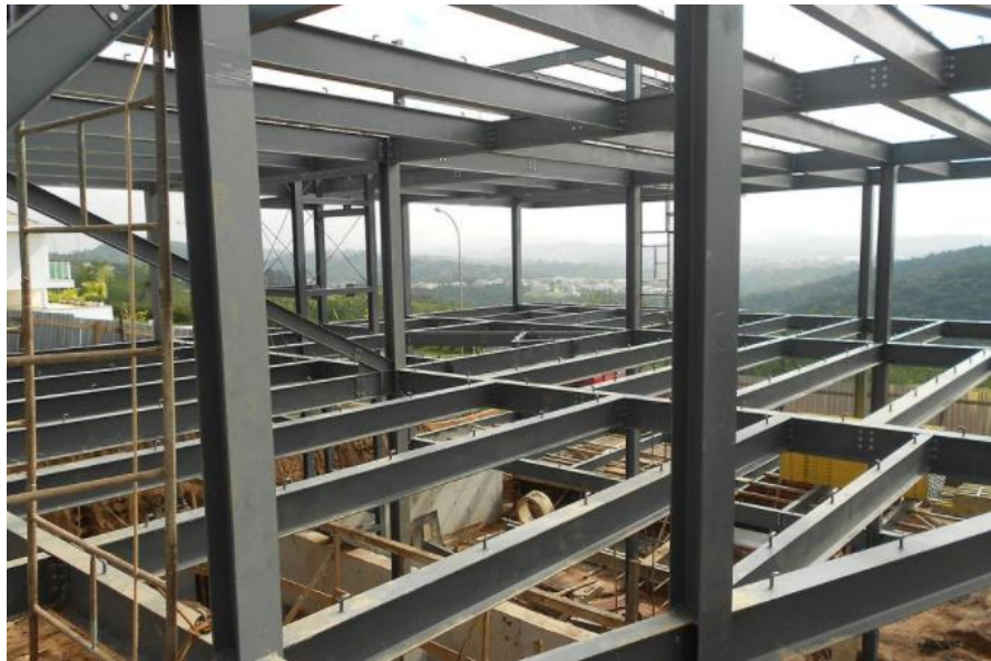
Figur 12. Rammekonstruksjon i stål. Foto: Rogerio Moreira
