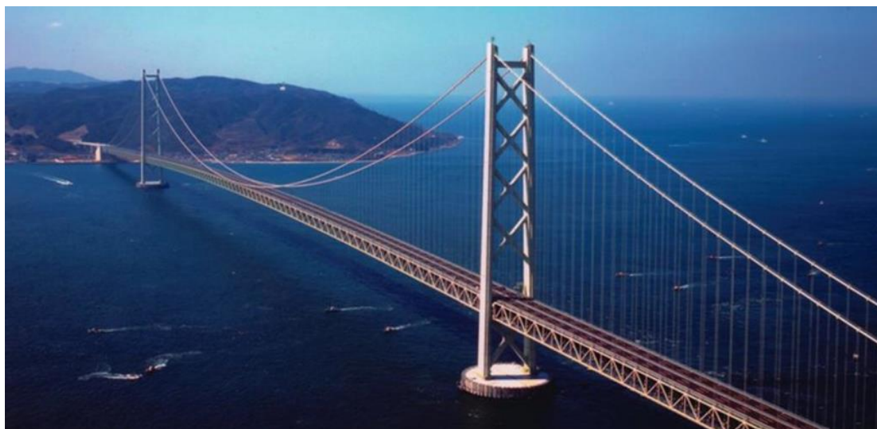
Figur 16. Akashi Kaikyo-brua i Japan. Foto: José S. Antunes do Carmo
