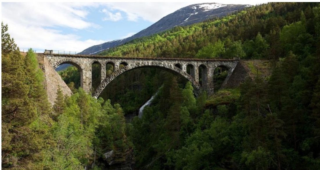
Figur 13. Kylling bru. Buekonstruksjon av steinblokker. Foto: broer.no
