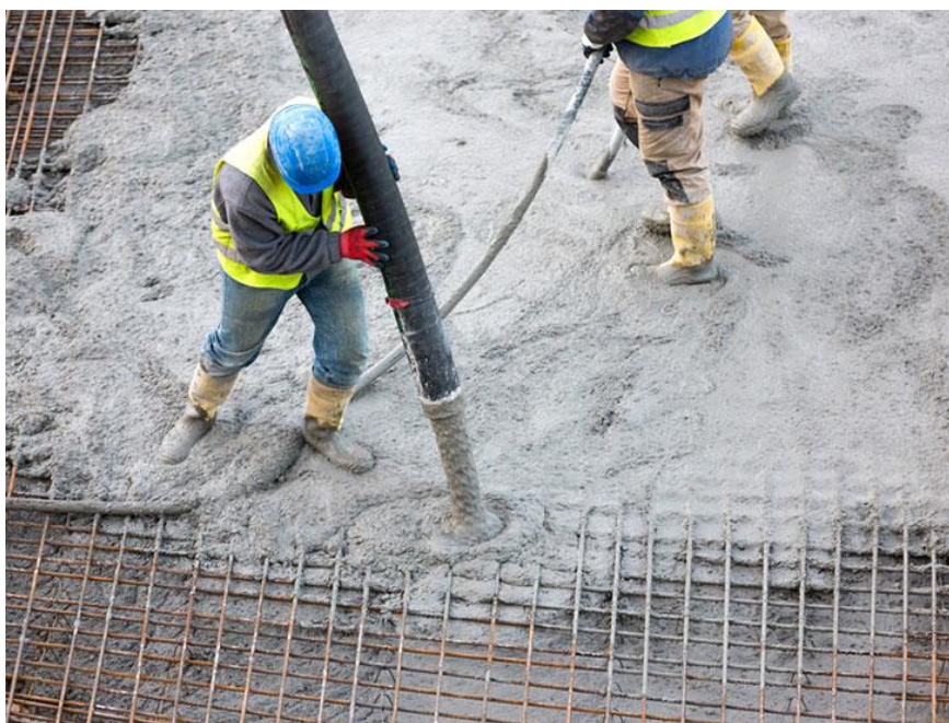
Figur 20. Betong som sprøytes over armeringsnett. Foto: Ağazadə Zəka
