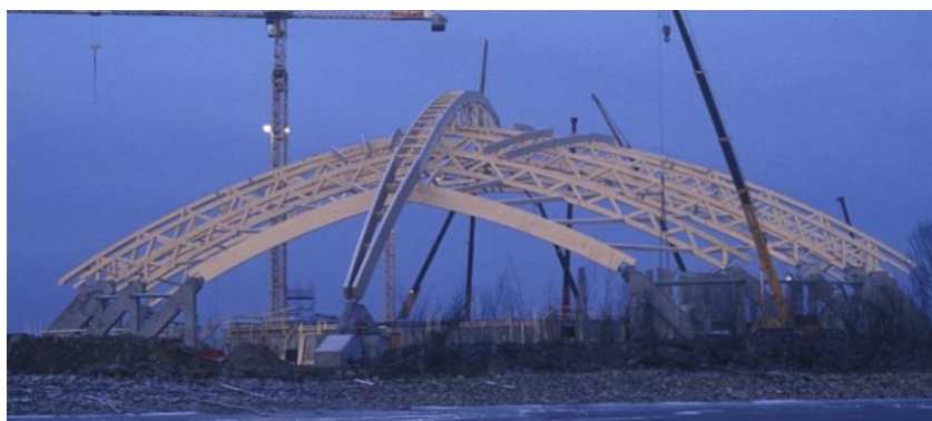
Figur 21. Fra byggingen av bærekonstruksjonen til Vikingskipet på Hamar. Foto: Mostue, Erik/Anno Domkirkeodden
