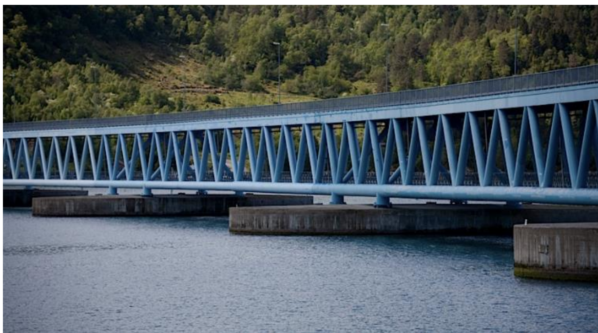
Figur 10. Bergsøysundbrua med fagverk i stål. Foto: broer.no
