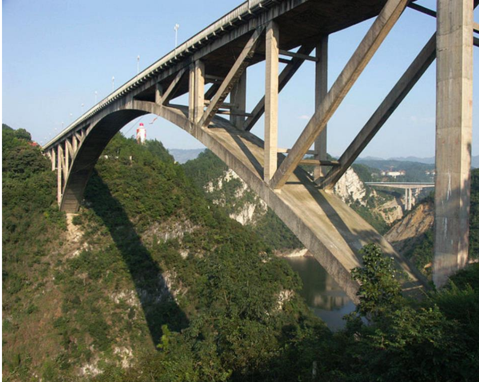
Figur 14. Betongbru formet som en bue. Foto: Eric Sakowski.
