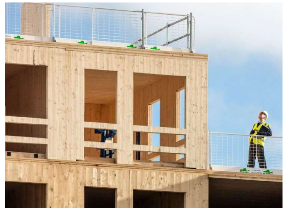
Figur 23: Massivtreelementene har midlertidig integrerte sikkerhetsgjerder på byggeplass. Foto: Waugh Thistleton Architects
