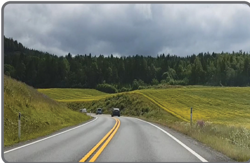
Figur 49. Eksisterende E134. Bilde fra befaringsbil
