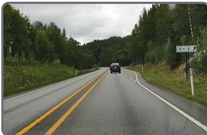
Figur 52. Eksisterende E134. Bilde fra befarings
