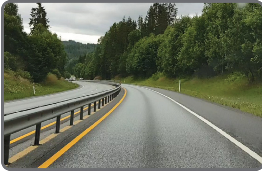
Figur 50. Eksisterende E134. Bilde fra befaring
