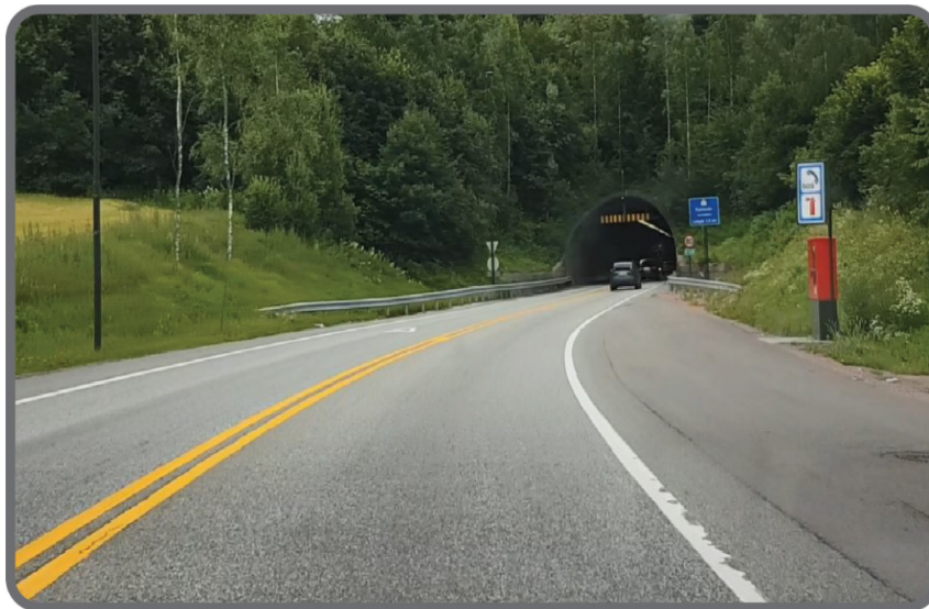
Figur 51. Eksisterende E134. Bilde fra befaring
