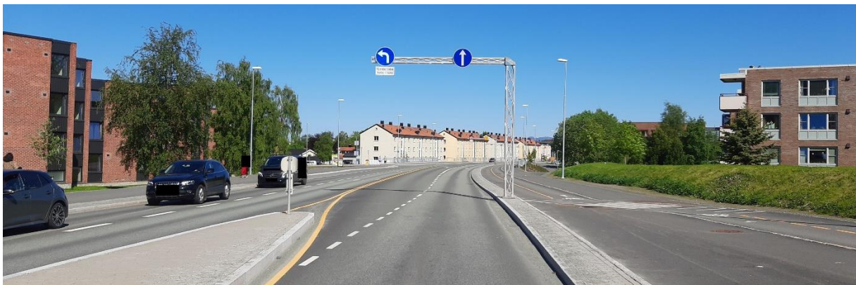
Figur 49 Påbudsskilt regulerer kjørefeltene mellom bussholdeplass Moholt Studentby og Bregnevegen. Legg merke til at påbudsskiltene er skiltet 100 meter før krysset med Bregnevegen.
