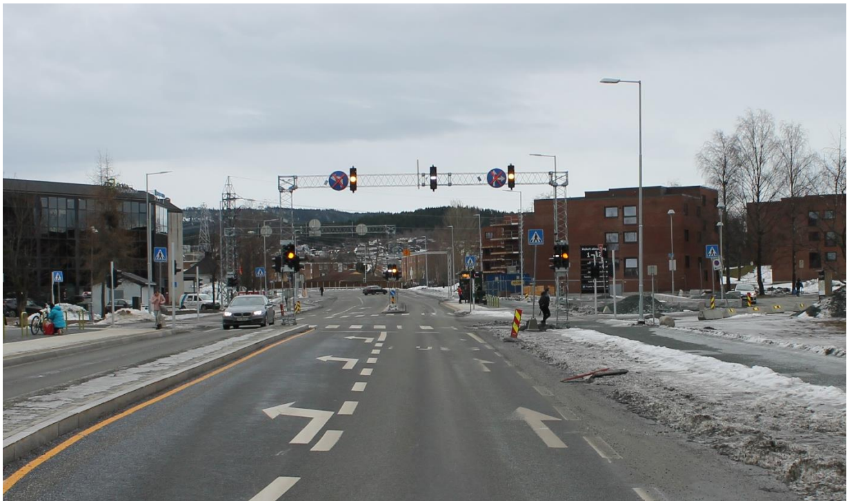
Figur 7 Frode Rinnans Veg-krysset sett fra nord den 20. februar 2020. Krysset står i gulblink og skilt er teipet over. Høyre felt er dekket av snø.
