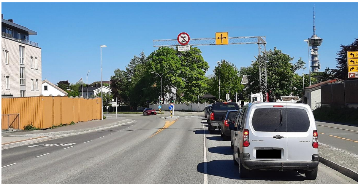
Figur 45 Dybdahlsvegkrysset sett fra Jonsvannsveien Sør. Vanlig trafikk må bruke høyre kjørefelt.
