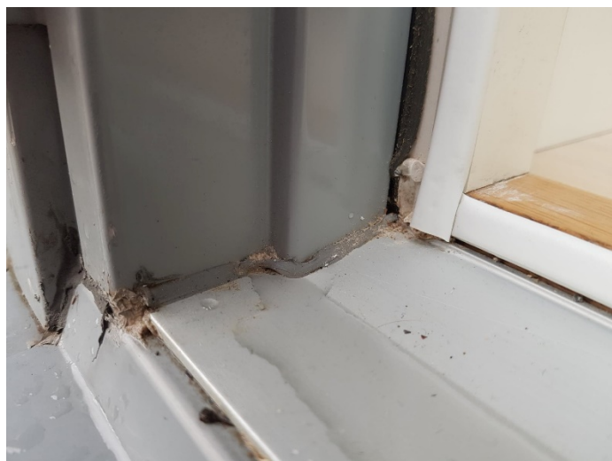
Figur 4.16: Viser terrassedørens sammenføyning mellom karm og terskel
