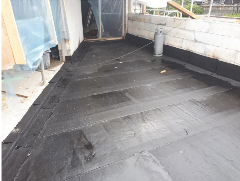
Figur 4.28: Bilde som viser membran, før flislegging.
