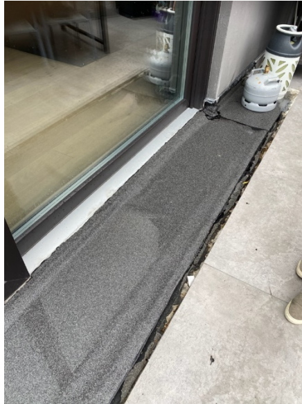
Figur 4.29: Bilde viser midlertidig løsning, med membran klebet på terskel.
