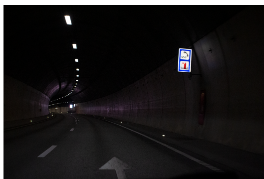
(b) Tunnelhvelving med lyspåvirkning
