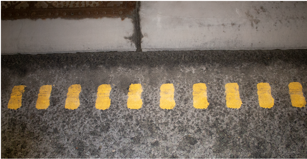
Figur 4.4: Asfalten med gulstripe inn mot banketten
