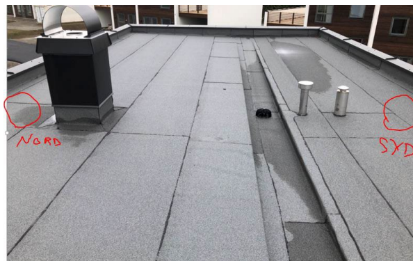
Figur 4-14, Uttak av taktroprøve ved sør- og nordside (Clementz og Young, 2019)
