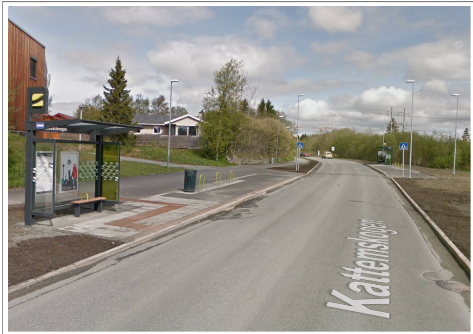
Figur 6.3: Kantstopp med fortau, og uten markeringer mellom kjørefelt på Bekkansinvegen
