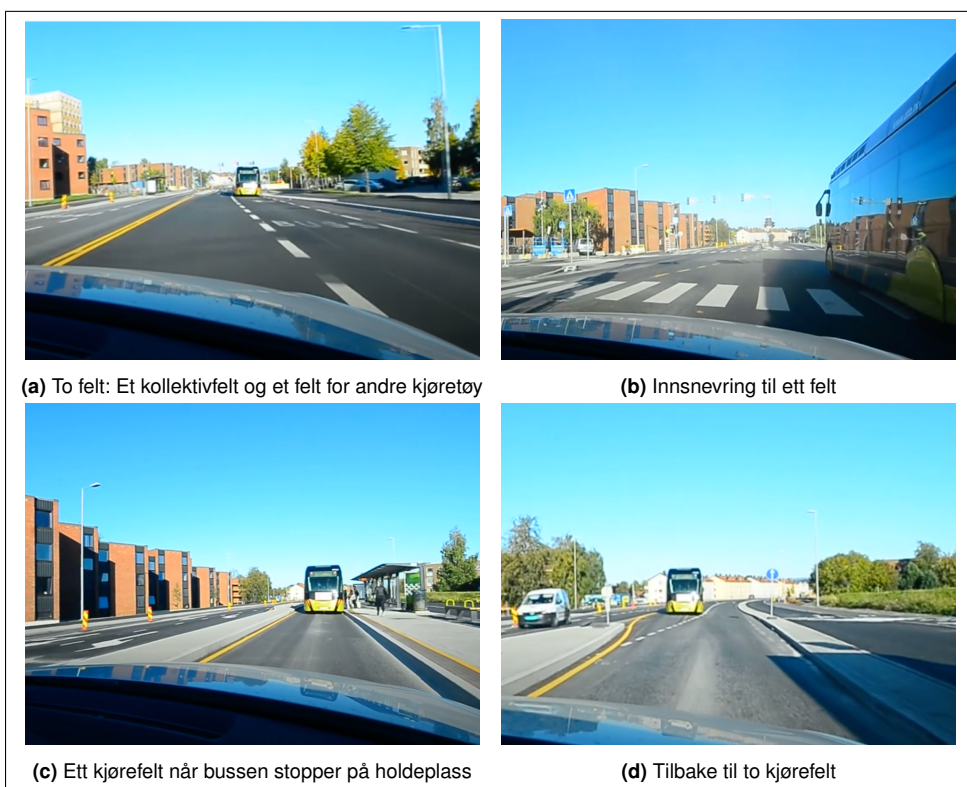
Figur 6.5: Bilder av kantstopp med timeglassutforming (Ulvnes, 2019)
