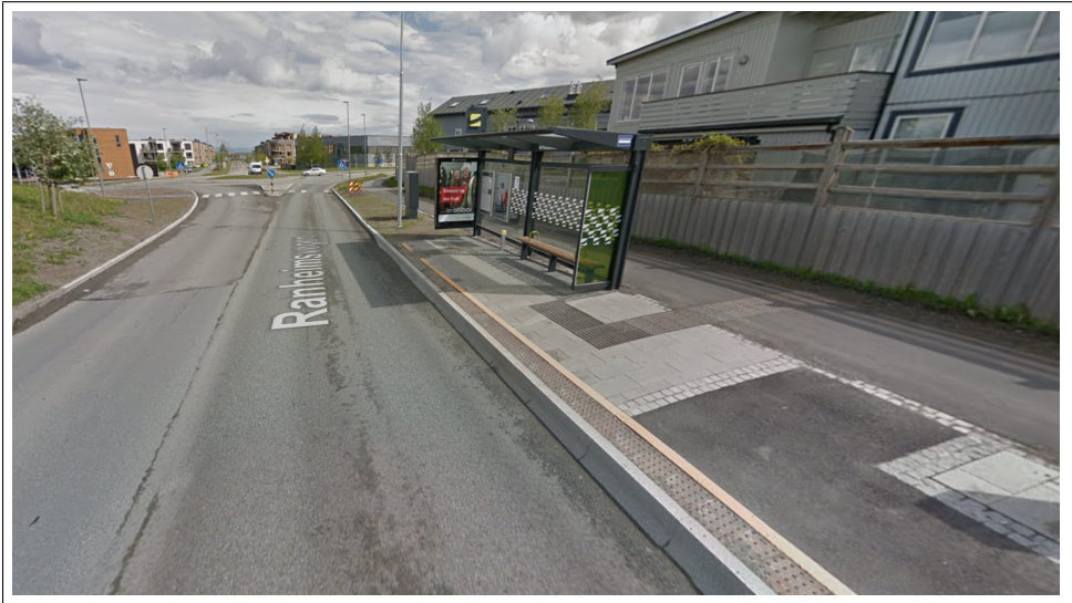
Figur 6.6: Kantstopp med gang- og sykkelveg på Grilstadkleiva
