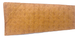
Eldre vindsperre, trolig fra 1936.
