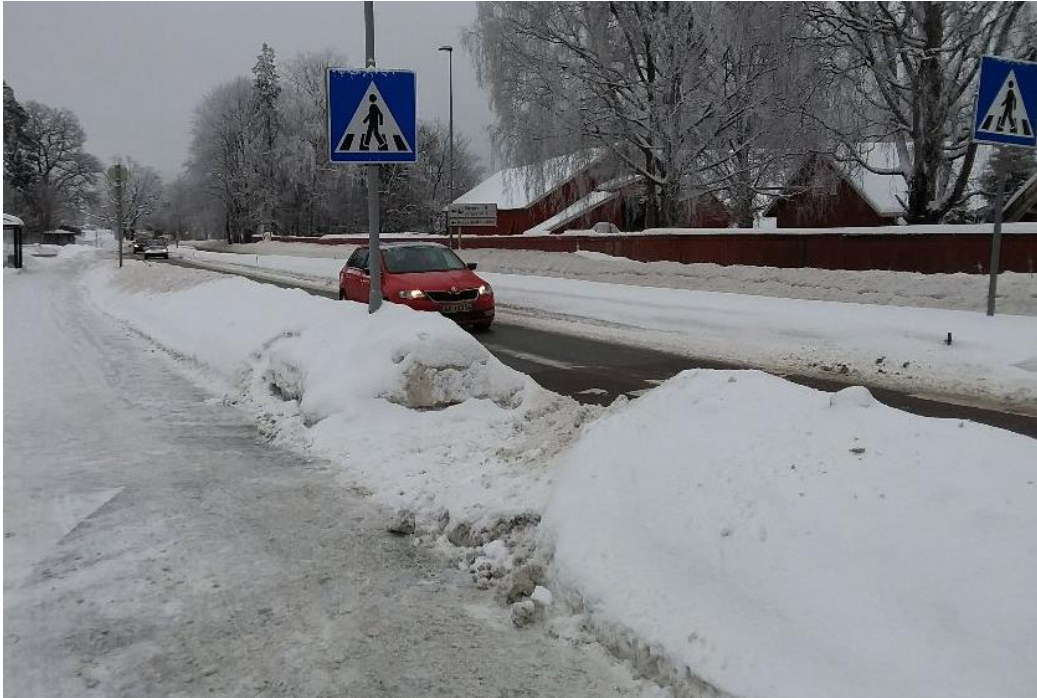
Figur 2.1: Byggherrene må følge opp at arbeidene i driftskontraktene utføres som avtalt. For eksempel rydding av snø ved fotgjengeroverganger. Bilde er hentet fra ELRAPP.
