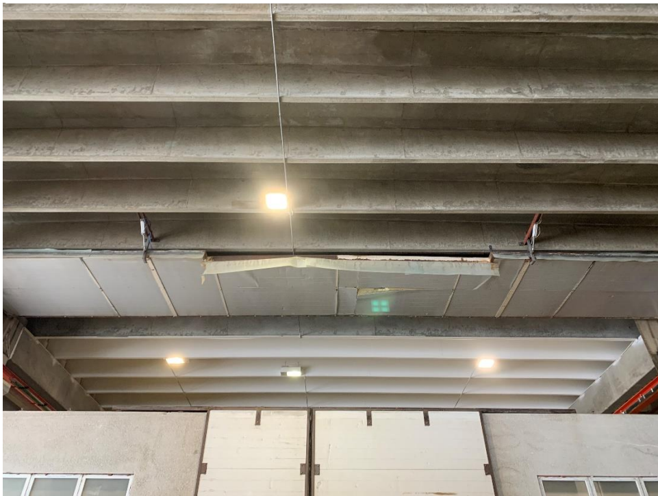
Figur 10 - Falletømmen over hovedport 2. Identisk på hovedport 1
