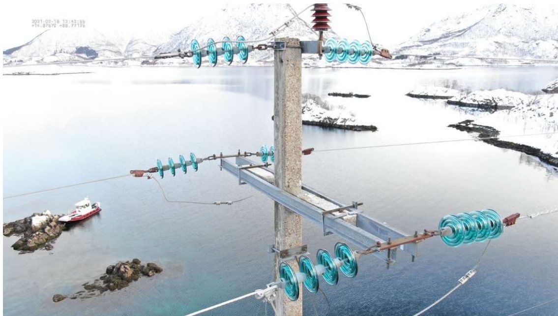
Figur 4.3: Eksempel på ståltravers
