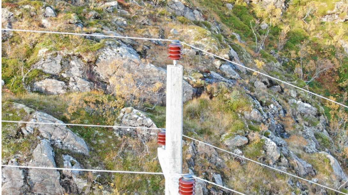
Figur 4.4: Piggisolatorer på hver fase
