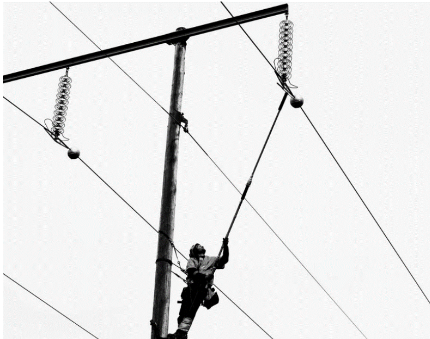
Figur 23: Installering av sensorkula på linje (Heimdall Power, 2021)
