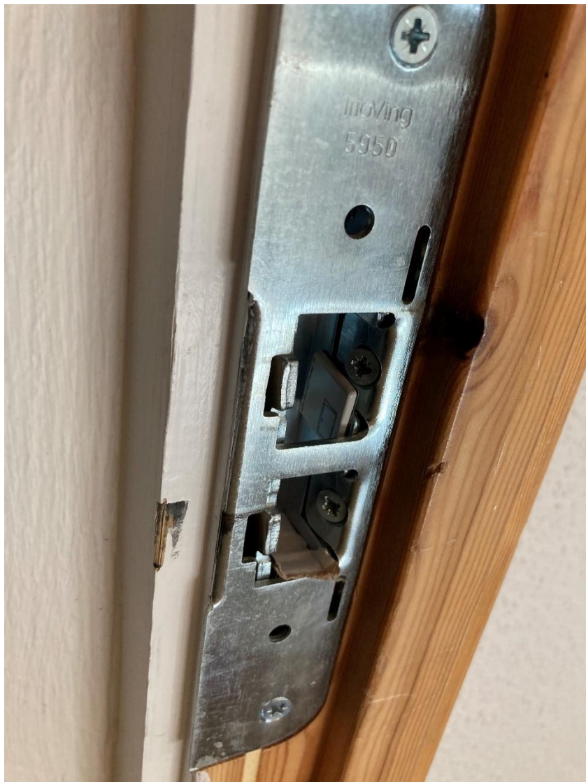
Figur 56: Plassering av sensor i låskasse
