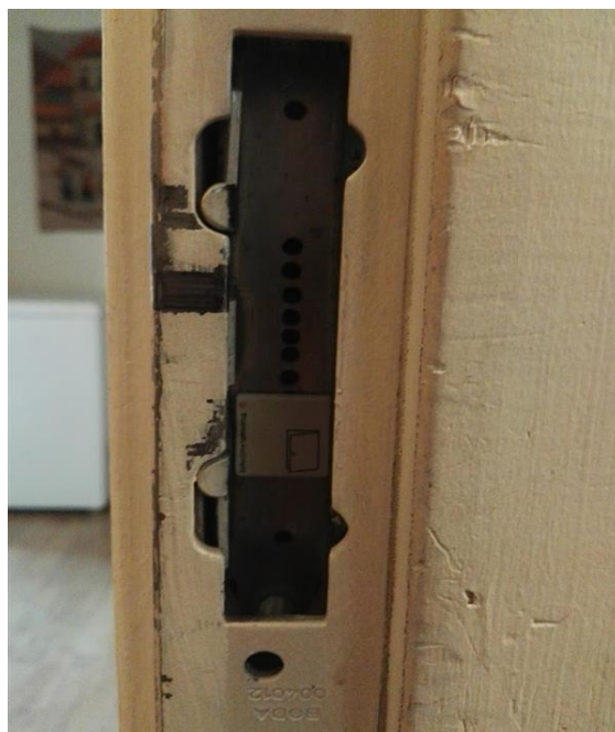
Figur 67: Sensor i låskasse
