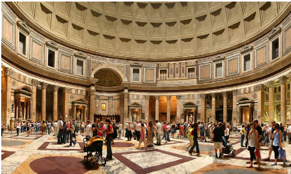
Pantheon i Roma ble bygget på 120-tallet e.kr. og har verdens største uarmerte betongkuppel.
