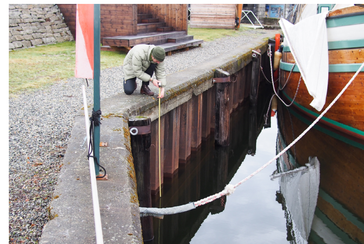
Måling av vannstanden på Vestre Kanalkai ved høyyvann
