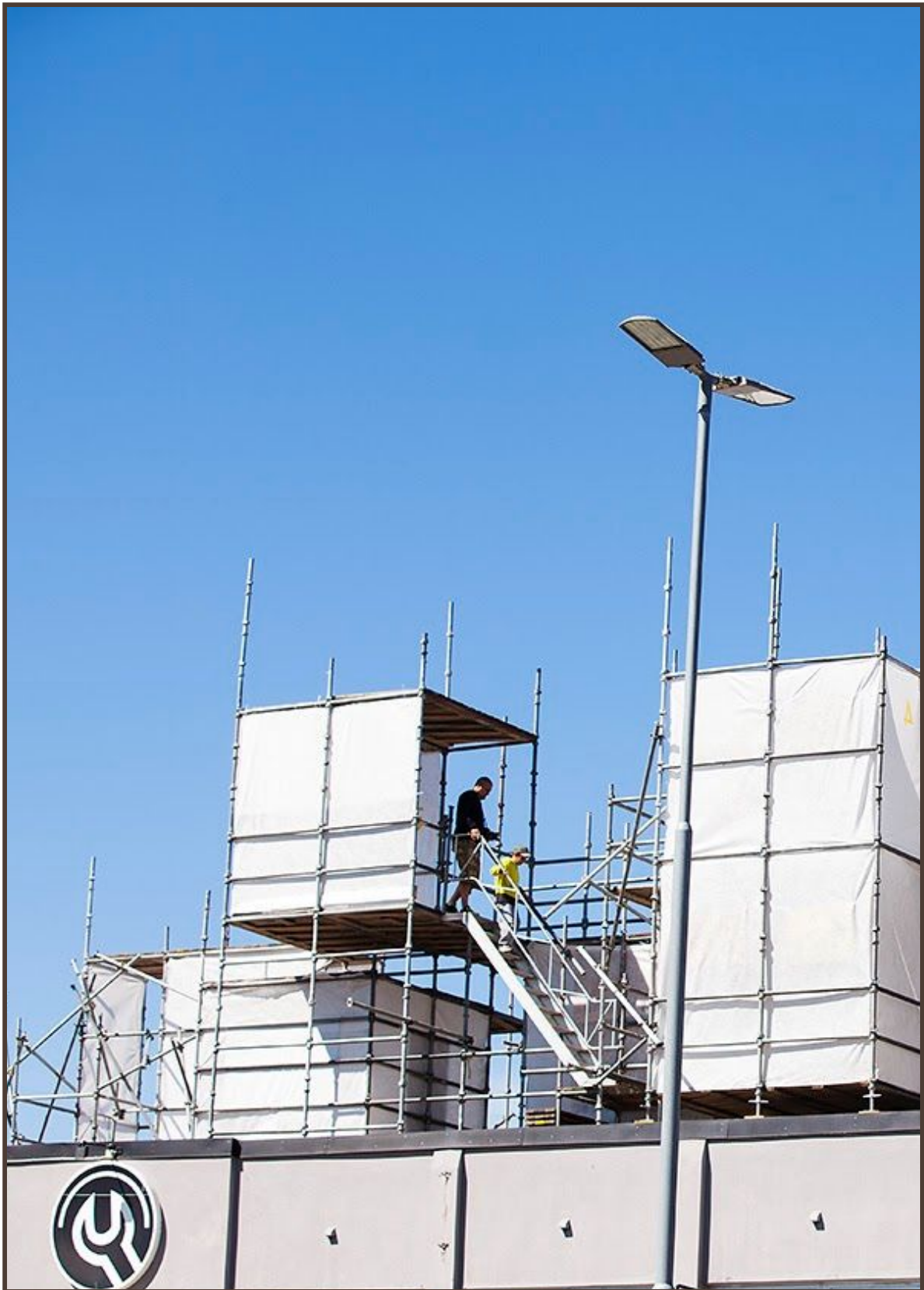
Making is Thinkings utstillingsinstallasjon på Fyringsbunkeren. Foto: Wil Lee-Wright
