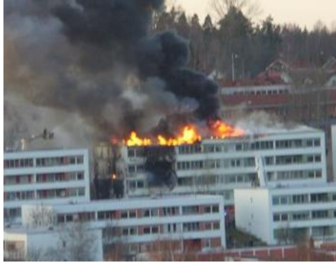
Figur B 3: Brannspredning til tak.
