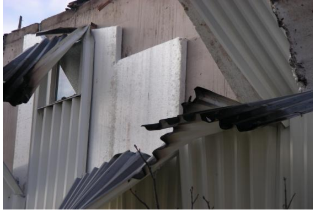
Figur 2: Detalj oppbygging av fasaden på gavl.
