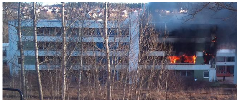
Figur B 2: Her har brannen spredt seg til kjøkkenet og videre under fasaden mot gavlveggen mot sør. Foto: Andreas Larsson, 15:46.
