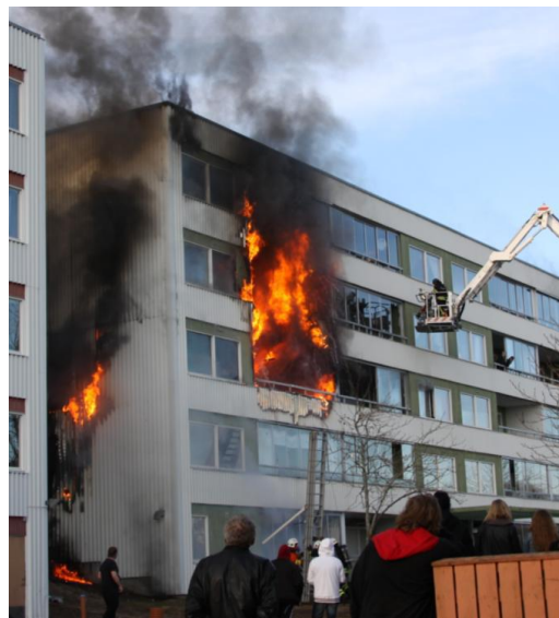
Figur 1: Brannspredning langs fasadene.
