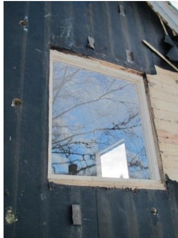
Figur 11: Innvendig test av plastvinduer
