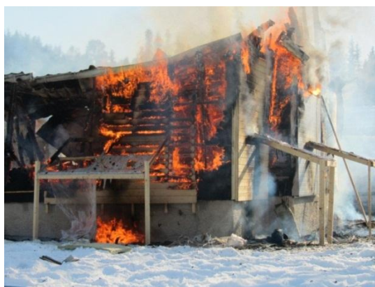
Figur 31: Nedbrenning av bygningen
