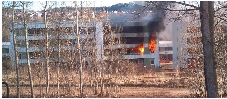
Figur B 1: Bygningens langside mot vest med startbrannrommet der flammene slår ut gjennom vinduer og dører. Foto: Andreas Larsson, 15:42.
