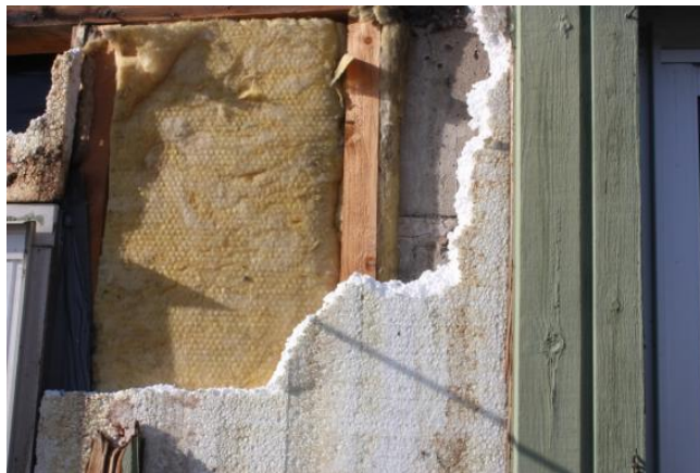
Figur 3: Detalj oppbygging av fasaden på langside.
