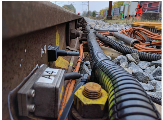
(b) WS on the rail-web (overview)
