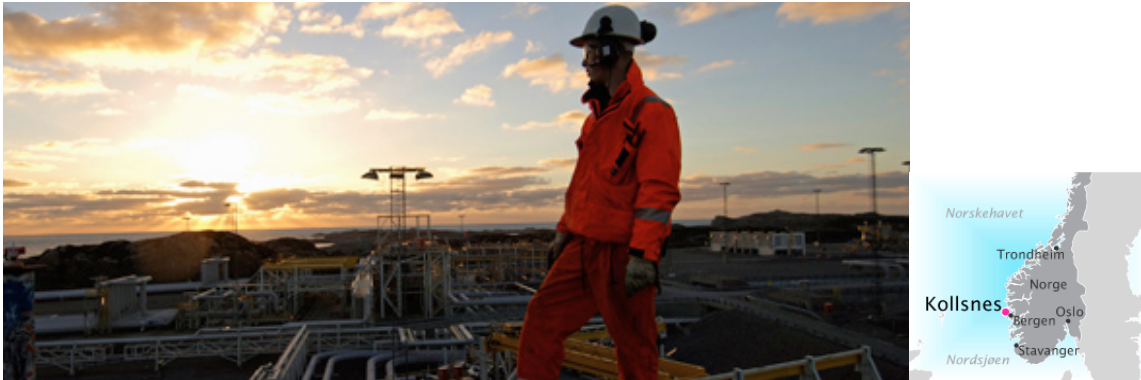
Bilde 3: Kollsnes Prosessanlegg (Entry)
