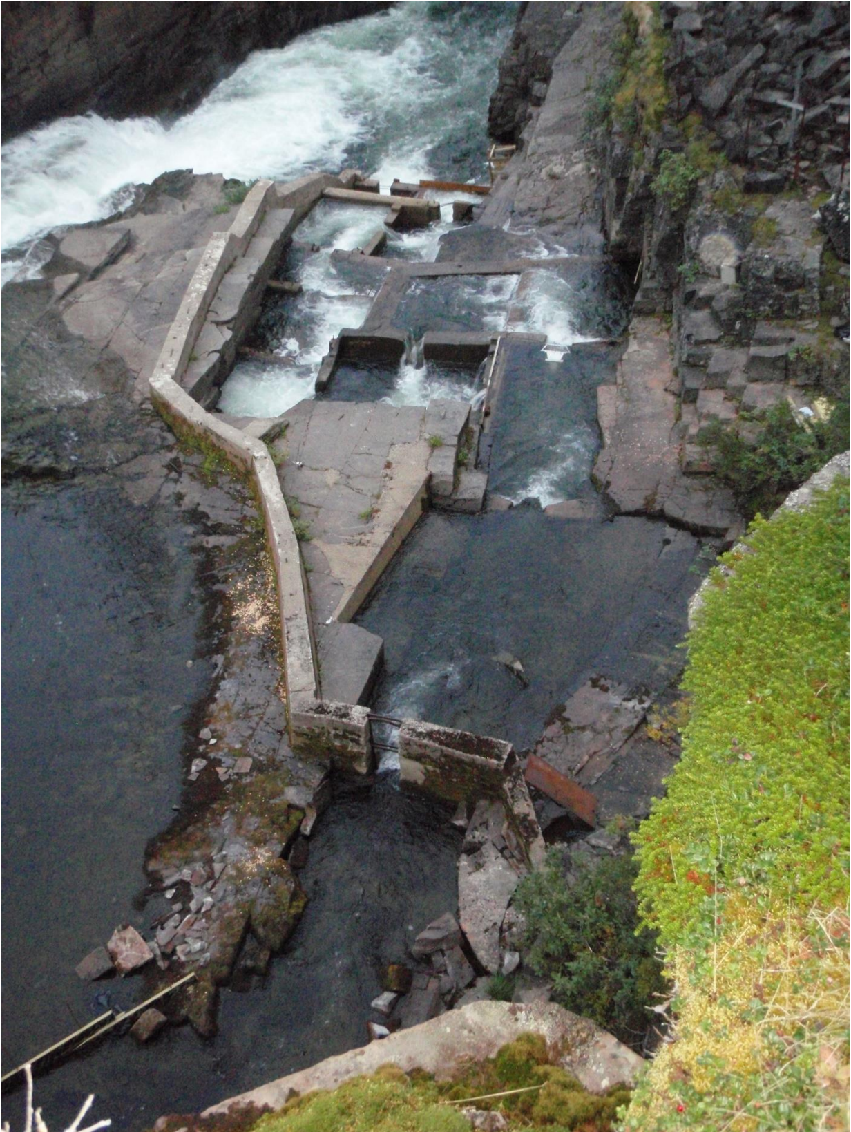
Fig. 44 Trappa med Førstefossen til venstre. Fisketelleren vises i terskel nummer tre.
