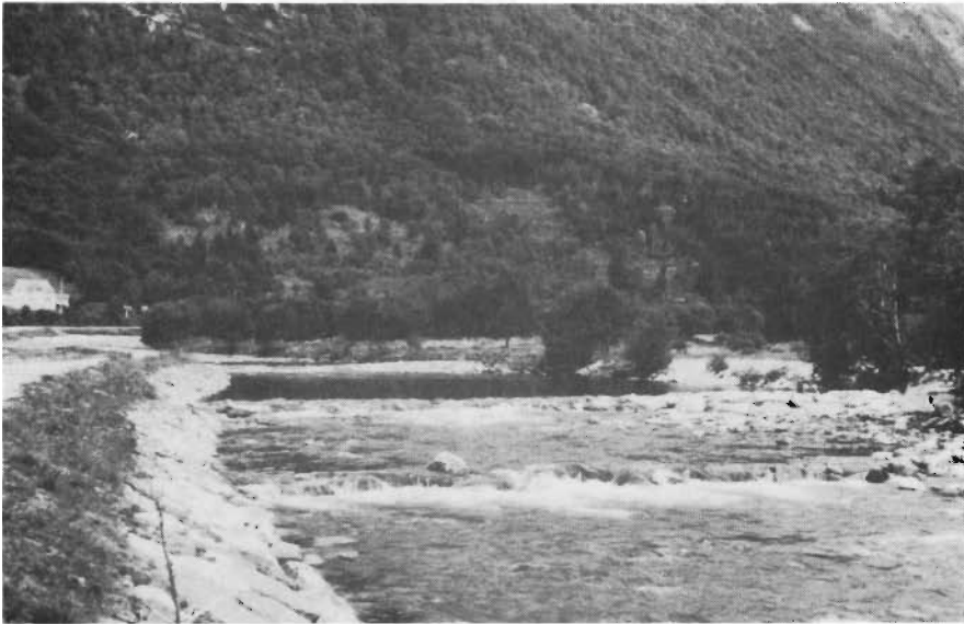
Fig. 13b. Nedre Visa ved Myklebostad sett motstrøms. Elveforbygning og terskler preger denne del av Visa.
