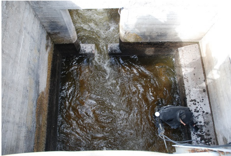
Figur 1.1: Fisketrapp med spalteåpning hentet fra CEDREN [5]. Foto: Jon Museseth.
