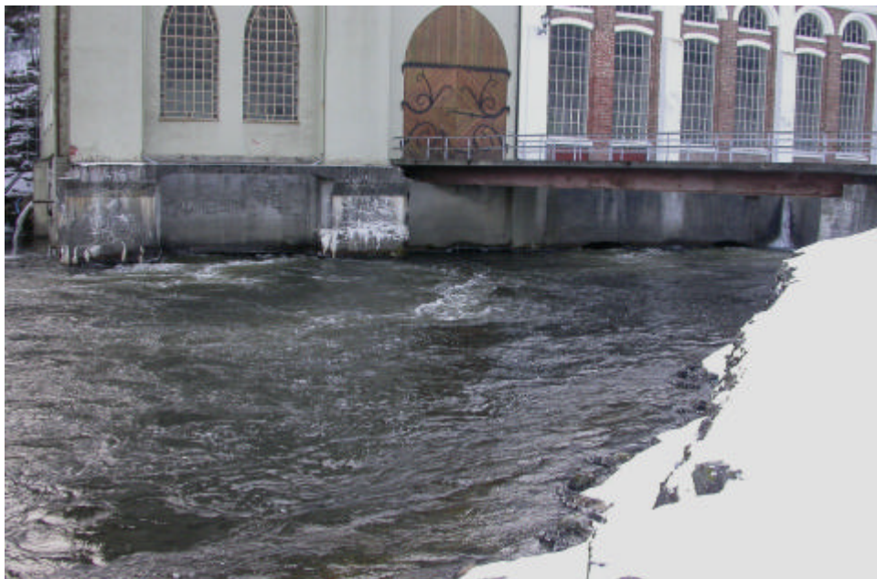
Bilde 1. Utløpet fra kraftstasjonen ved Øvre Leirfoss. Foto: Jo V. Arnekleiv
