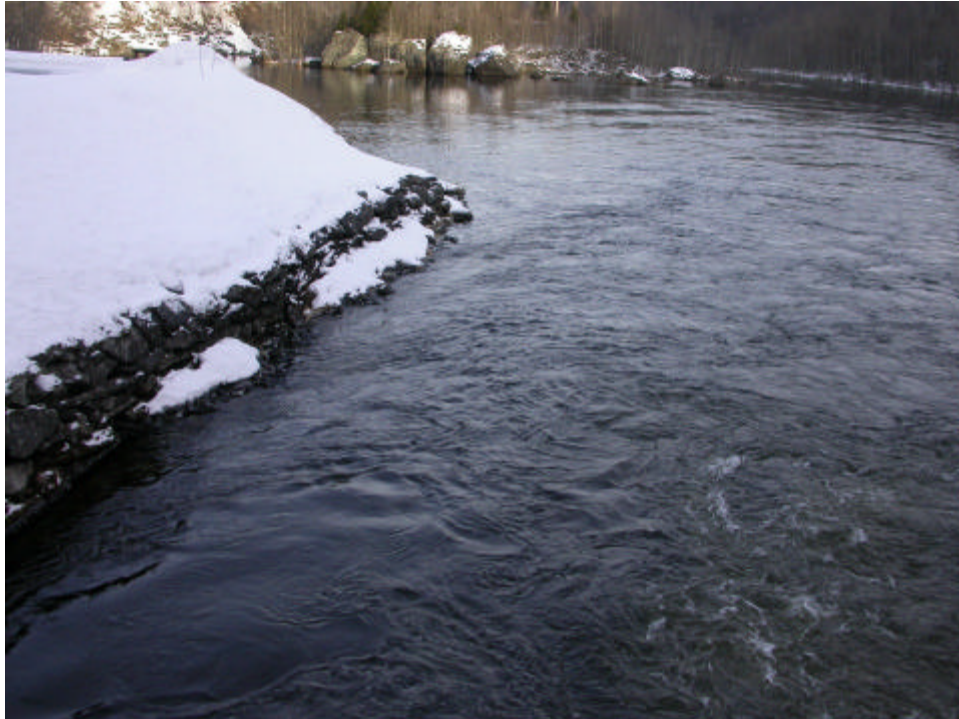
Bilde 2. Utløpskanalen ved Øvre Leirfoss sett fra gangbrua og utover mot hølen under fossen. Foto: Jo V. Arnekleiv
