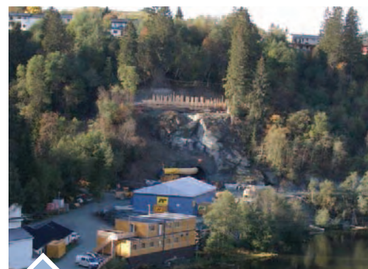
Anleggsområdet for nye Leirfossene kraftverk: tunnelinngangen til kraftstasjonen. Det er bare inngangsportalen som blir synlig når anlegget står ferdig høsten 2008. Foto Mikal Sveen, TEV.
