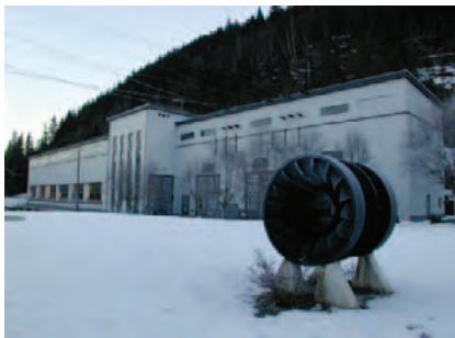
Svean kraftverk ble satt i drift i 1940.
