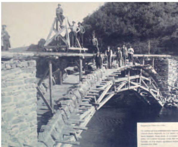
Tillerbrua er under bygging. Bildet er datert 1913. Teksten nederst til høyre på bildet angir navnene til de fleste arbeiderne. Ukjent fotograf.
