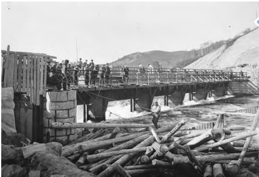
Tømmervase ved fossenakken til Nedre Leirfoss på 1920-tallet. Legg merke til tømmerfløteren ytterst på lunna på fossenakken! Tømmerrenna starter til venstre.
