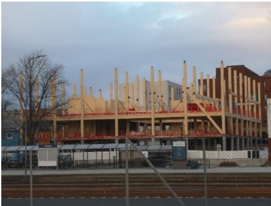
Figur 11 O2-bygget under bygging (eget bilde)
