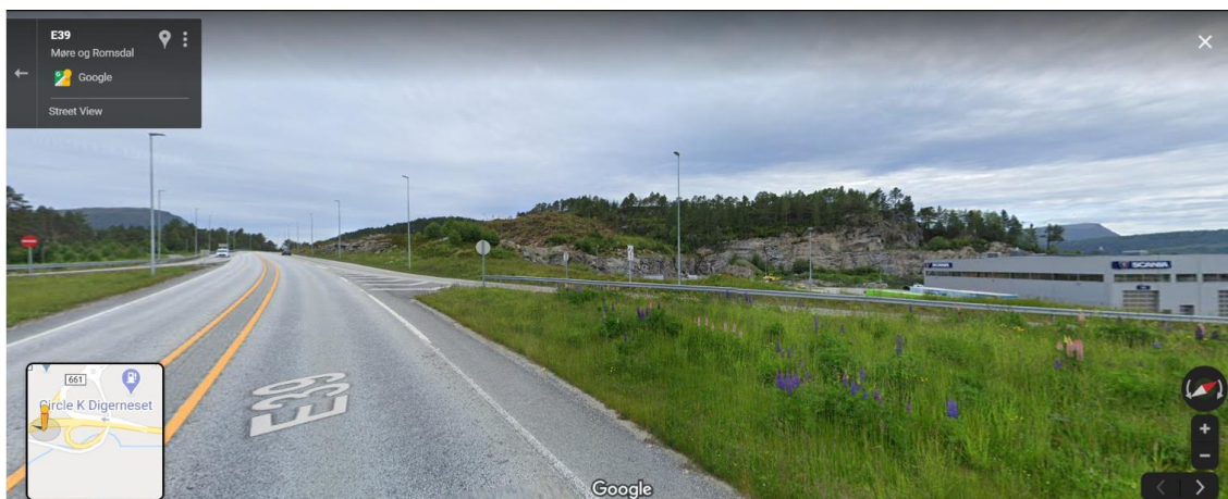
Bilde 1: Digernesskiftet med mulig utløpspunkt for 2-løpstunnel til høyre i fjellveggen
