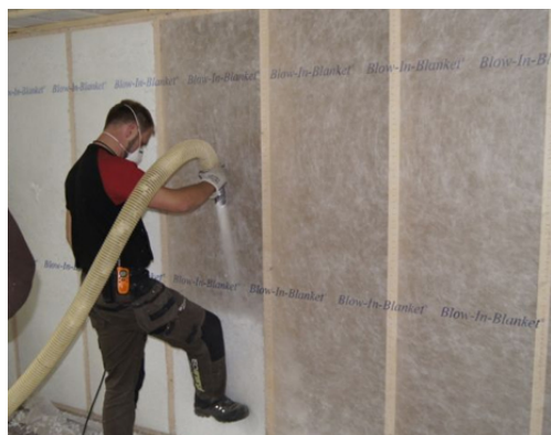
Figur 3.18 En person som jobber med blåseisolasjon [45]
