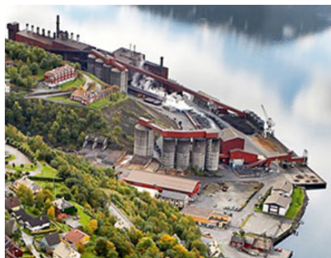
Figur D.2: Smelteverket i Tyssedal
