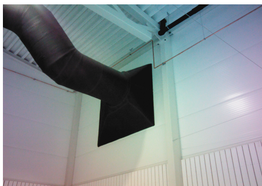
Figur V2.6: Avkastkanal og avkast sett innenfra
