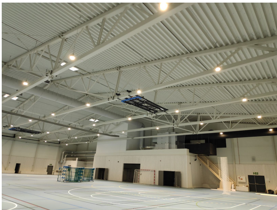
Figur 2.5: Plassering av ventilasjonsaggregat i hovedhall
