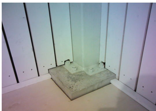
Figur V2.3: Sør-vestlig hjørne av fundament med fotplate og bygningsøyle
