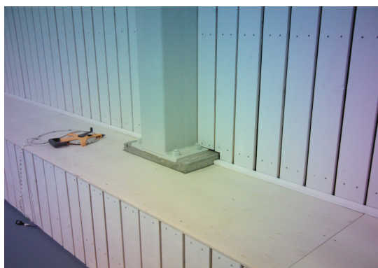
Figur V2.2: Fundament med fotplate og bygningsøyle langs sør-vestlig vegg i hallen sett på skrå
