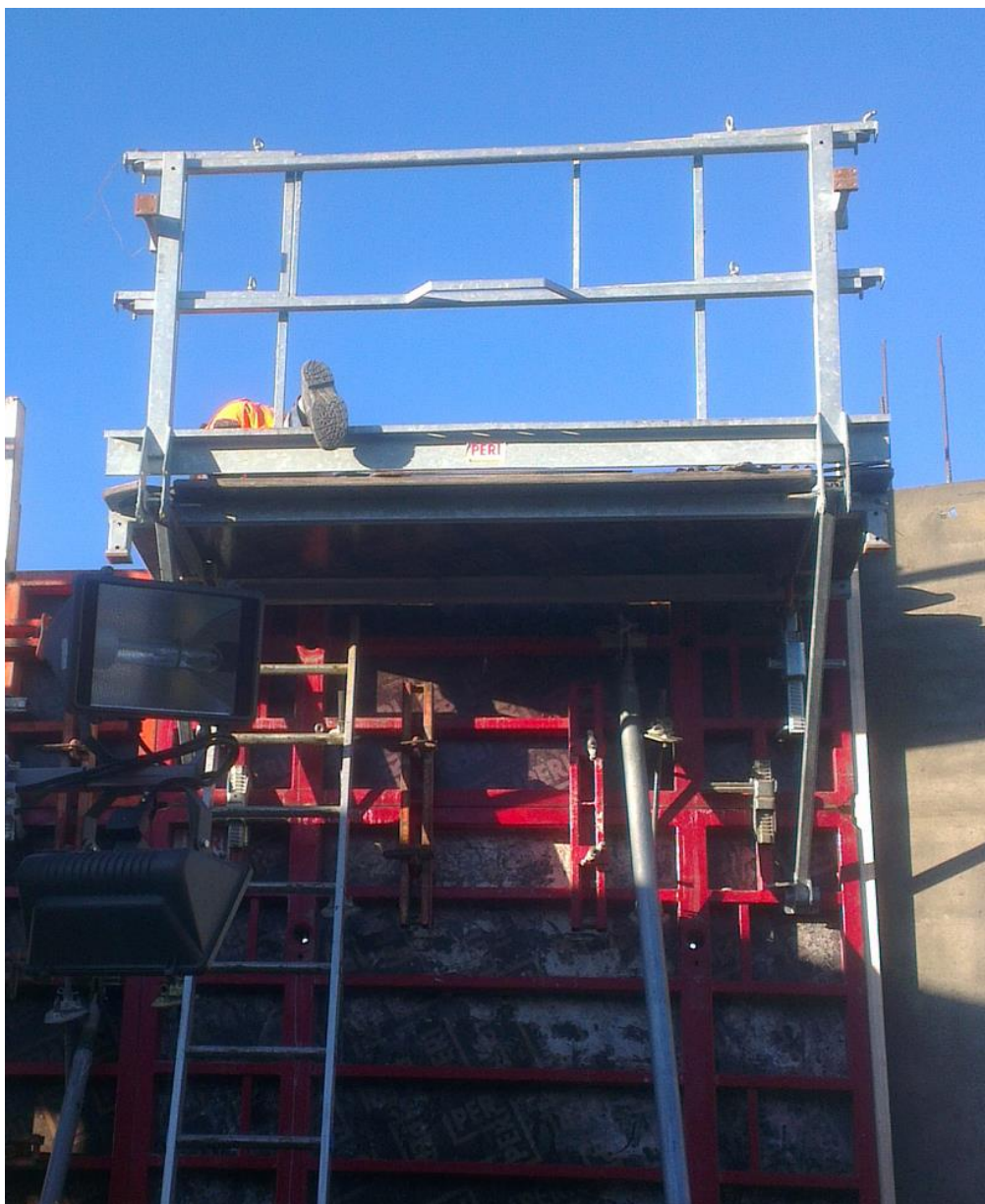
Figur 1. Ikke godkjent arbeid i stillas
